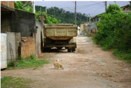
Figura 19: Rua Minas Gerais na parte de cima. Notar a ausência total de infra-estrutura e os processos erosivos na rua. Foto F. S. Lima.
