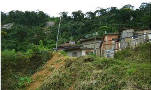
Figura 8. Canos de abastecimento de água ilegal, presentes por toda a comunidade. Foto F. S. Lima.
