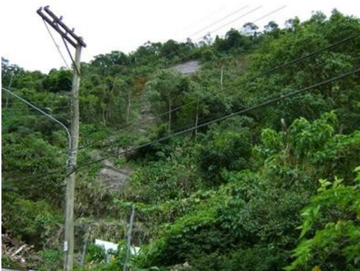
Figura 6. Cicatriz de deslizamento. Foto F. S. Lima.
