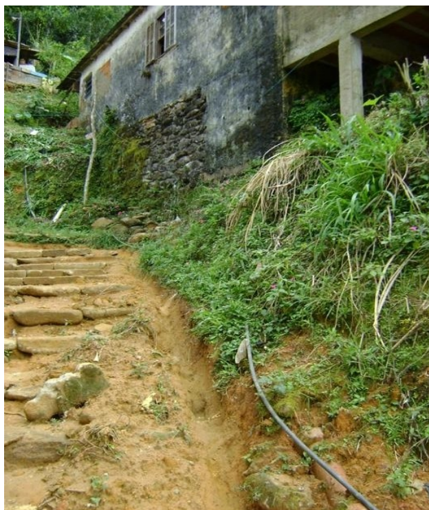
Figura 10. Pequena canaleta feita pelos moradores para escoar a água que desce a encosta em dias de pluviosidade intensa. F. S. Lima.
