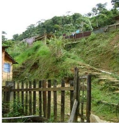
Figura 11: Escadaria rudimentar feita pelos próprios moradores e casas de madeira na Parte alta da ocupação. Foto: Fabio S. Lima
