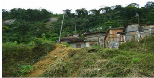
Figura 13: Baixa qualidade estrutural das moradias e proximidade do afloramento rochoso. F. S. Lima.
