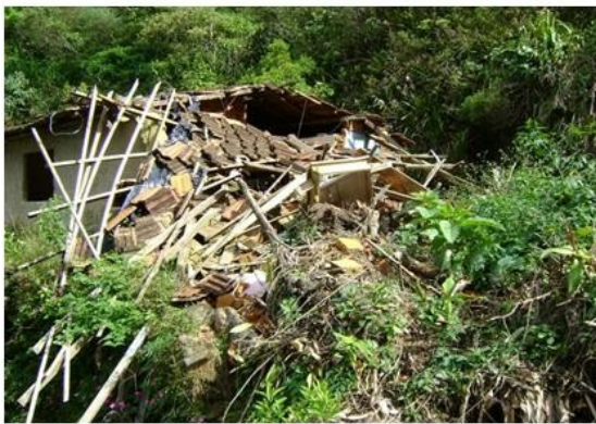
Figura 4: Destroços da casa que foi atingida por deslizamento de terra. Foto F.S. Lima.
