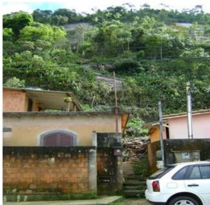
Figura 7. Casas muito próxima do afloramento rochoso. Declividade da encosta: 67°. Perigo de novos deslizamentos. Foto F. S. Lima.
